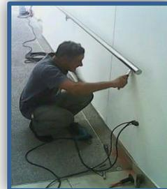
Ilustración 9 reinstalación de pasamano flotante
