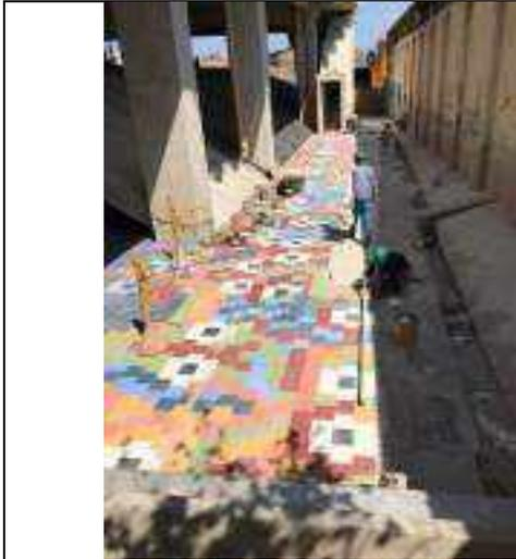
Avance de la instalación del piso en baldosa pompeyano en la fachada sur del proyecto.
