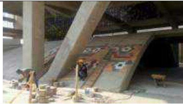
Avance en la instalación de la baldosa hidráulica sobre la bóveda del proyecto.
