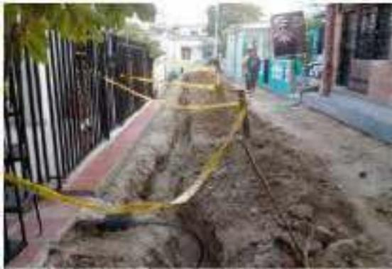
*Ilustración 1- Excavación para instalación de tubería 110 mm en la calle 45F entre carreras 1C y 104, Ciudadela 20 de Julio.*
