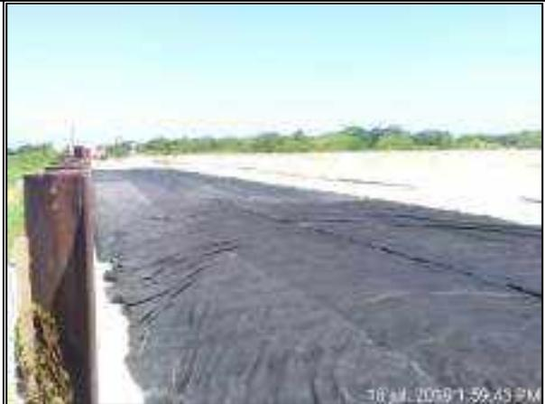
Extendido de geotextil para capa drenante
