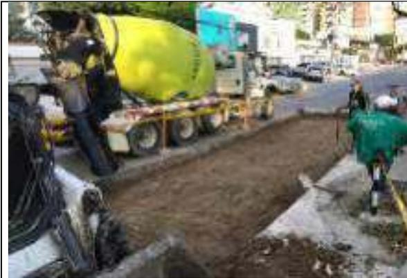
Excavación previa instalación de concreto fluido en carrera 47 entre calle 82 y 84
