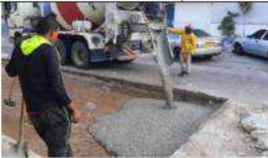
Instalación de concreto fluido en carrera 47 entre calle 74 y 72
