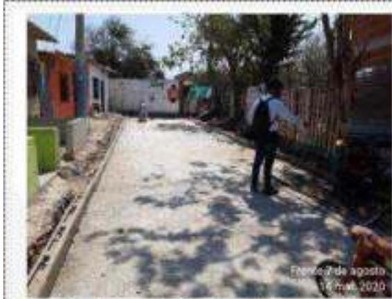
Ilustración 10 Instalación de rieles para posterior fundida de pavimento en la CRA 12 CON CALLE 99B (7 de agosto)
