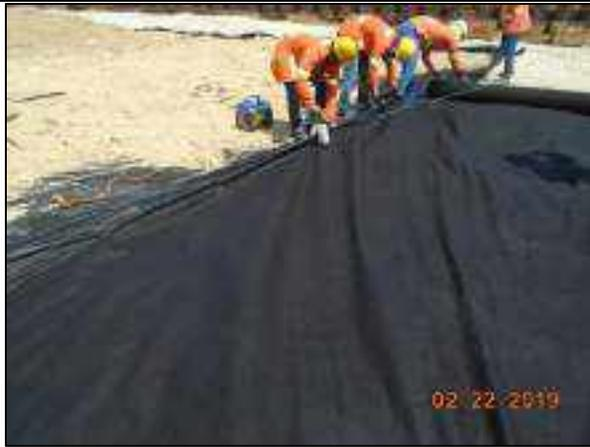
Extendido de geotextil conformación de terraplén
