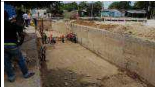
Iniciando armado del refuerzo en placa de fondo y muros del Box de entrega al arroyo Rebolo sobre cra 25
