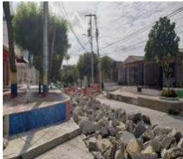
Demolición de pavimento rígido existente en la carrea 11 entre calle 35 y 35a
