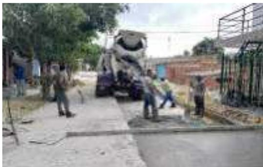
Instalación de concreto 45 MR sobre Calle 84 con 21D.
