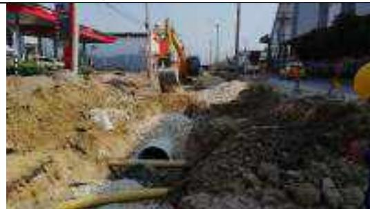
Trabajos de instalación de colector de 33" entre carreras 23 y 24, calzada occidental.
