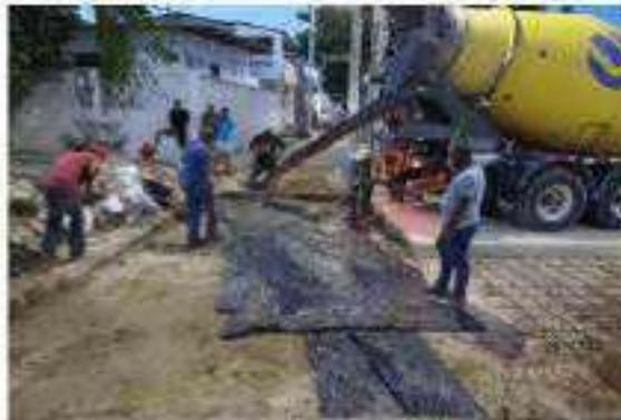
*Ilustración 2 – Vaciado de concreto para pavimento, intersección calle 47ª con carrera 3 sur, Ciudadela 20 de Julio.*
