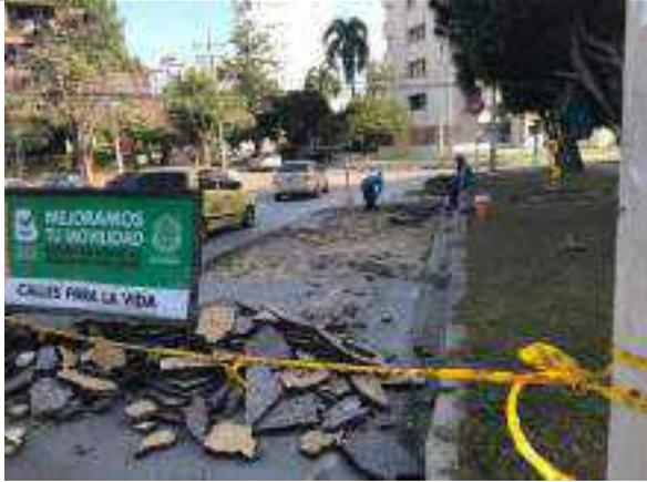
Demolición de concreto asfáltico en carrera 52 entre calle 87 y 86
