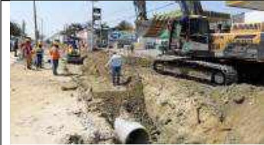
Instalación de nuevo colector de 33" en la calzada occidental entre cra 22 y 23
