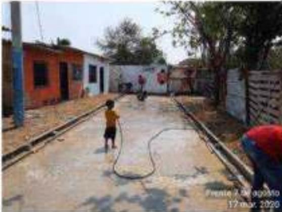
Ilustración 12 Arreglo de terreno para posterior fundida de andenes en la CRA 12 CON CALLE 99B (7 de agosto)
