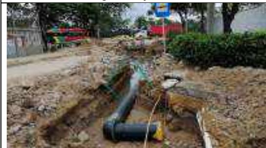
Tubería de agua potable PEAD 400 mm para quitar la interferencia en la cra 4
