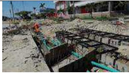
Instalación del banco de ductos en la bocacalle de la cra 6, y construcción de captaciones.
