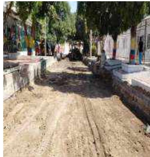
*Excavación, perfilación y compactación de la banca en la calle 36b entre carrera 17 y 19*
