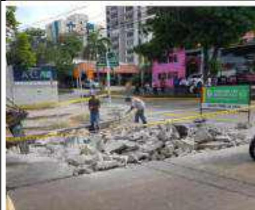
Demolición de pavimento en calle 79 entre 51b y 52
