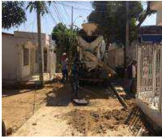
Fundida de concreto rígido en la calle 44 entre carrera 3c y 3b
