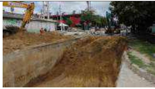
Excavaciones con máquina para construcción del box colector sobre la cra 25
