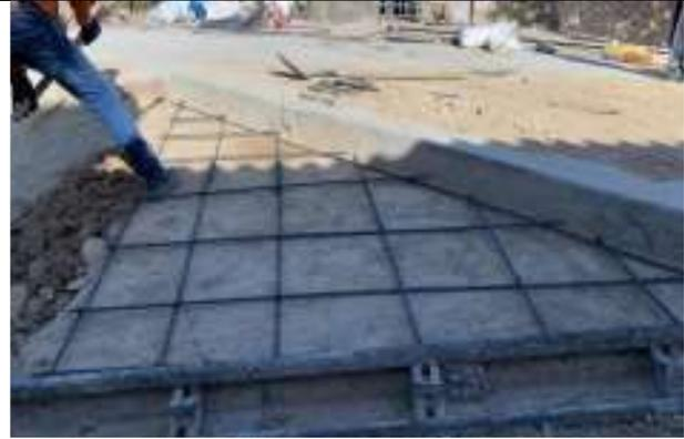
Imagen 10. Corte y figurado de acero de refuerzo – Módulo III
