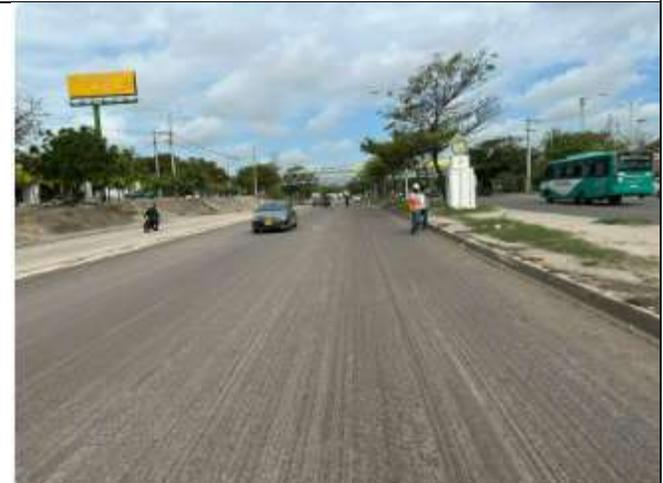
Imagen 23. Vía Circunvar sentido sur norte a las alturas del puente de villa de San Carlos. - longitud total demolida de asfalto → 502ML x 9.0 de ancho x 0.05m- Módulo 7.
