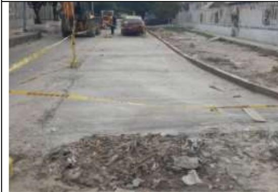
Imagen 5. Carrera 19 entre calle 31 y 35. Barrio BOYACÁ. Espesor de vía - 0.20m de espesor. MR45 Estructura. - Módulo 1.
