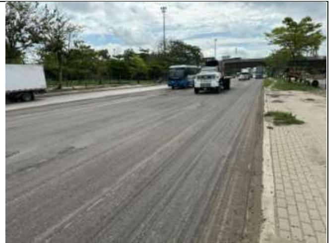
Imagen 21. Vía Circunvar sentido sur norte a las alturas del puente de Murillo. - longitud total demolida de asfalto → 73.0ML x 8.0m de ancho x 0.05m de espesor. - Módulo 7.
