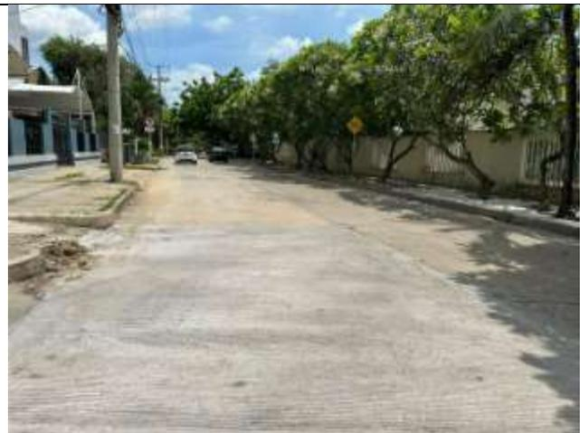
Imagen 14. Carrera 64 entre calles 94 esquina (lado izquierdo)- Longitud en fluido —> 6.0ML x 4.0m de ancho x 0.15m de espesor. – Módulo 5.
