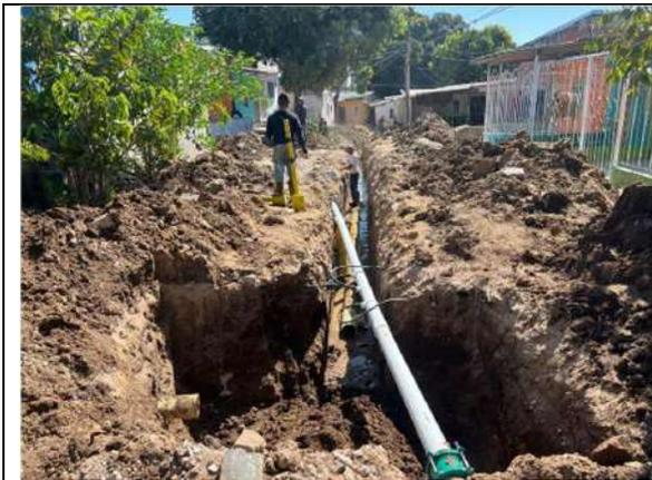
Imagen 1. Excavación para tubería de alcantarillado y domiciliarias. – Módulo 1
