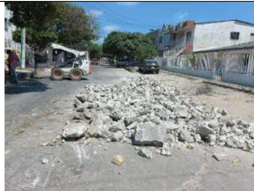
Imagen 6. Carrera 19 entre calle 31 y 35. Barrio BOYACÁ. - Demolición de pavimento → 16.40ML x 4.0m de ancho - Módulo 1.
