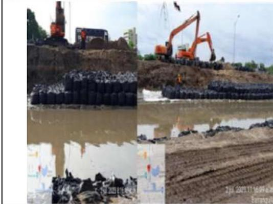
Imagen 3 Instalación de geobolsas entre las abscisas K2+720 – K2+750
