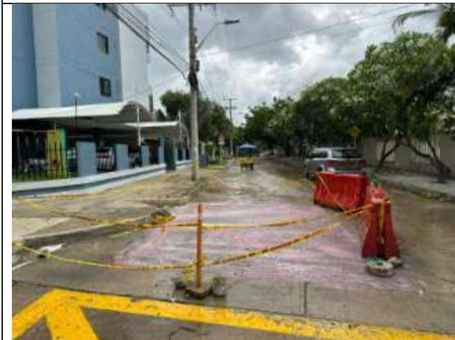
Imagen 13. Carrera 64 entre calles 94 esquina (lado izquierdo). Longitud total para reparar en pavimento rígido — > 6.0ML x 4.0m de ancho. – Módulo 5.
