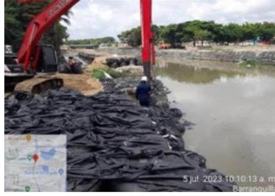
Imagen 4 Instalación de geobolsas entre las abscisas K2+710 – K2+720
