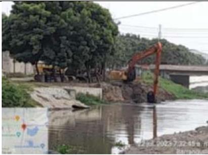
Imagen 5 Excavación para la conformación del talud sobre el costado derecho a partir de la abscisa K3+000
