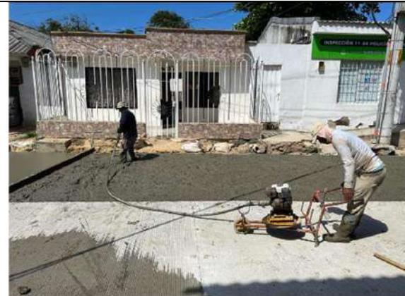
Imagen 17. Vaciado de losa de pavimento rígido - Módulo 6
