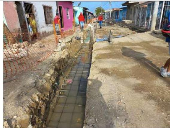
Imagen 12. Armado de acero de refuerzo de losa – Módulo 5
