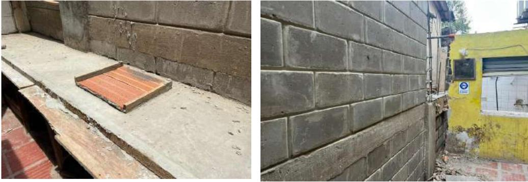
**IED.SANTA MARÍA:** Implementación de aleros perimetrales en bloque de bachillerato, impermeabilización de placas por afectación de cubiertas y cielos rasos. **AVANCE:** 85% en ejecución.
