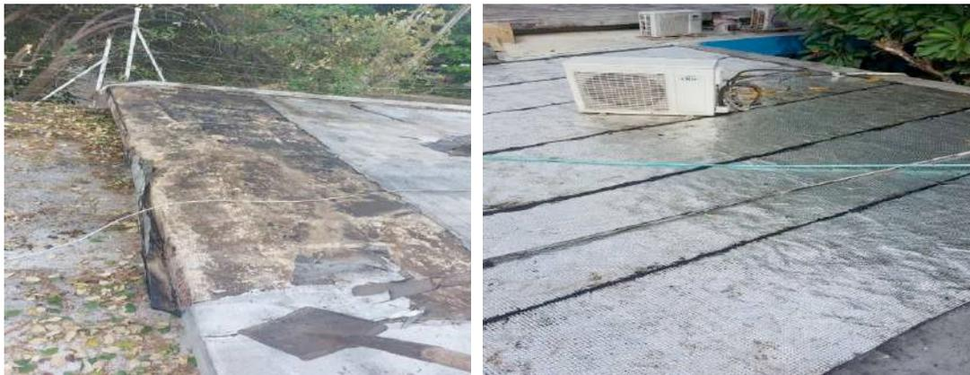
**IED. MUNDO BOLIVARIANO:** Impermeabilización de muros con aplicación de hidrófugos en losas reemplazo de cielos rasos en aula afectadas y retiro de manto afectado y reemplazo de nuevos mejoramiento de losa de cubierta y de los muros del cuarto de subestación. **AVANCE:** 100 % ejecutado.
