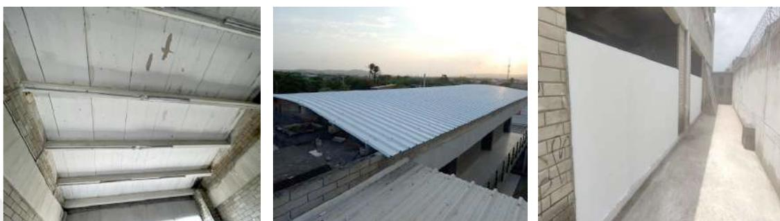
**IED.ALFREDO CORREA DE ANDREIS:** Construcción de muro de cerramiento, rehabilitación de muro externo, mantenimiento de cubierta y cielo raso en 2 aulas. **AVANCE:** 100 % ejecutado.
