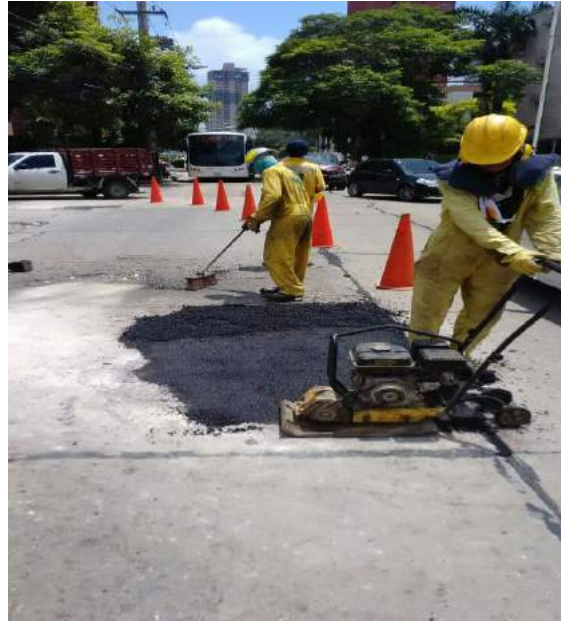
Imagen 02. Reparación de hueco en intersección.
