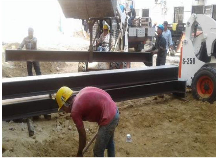
Acopio de IP para columnas en área de acopio
