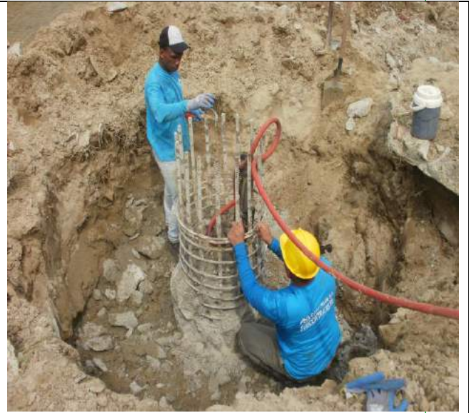
Imagen 2. Descabezado de pilote, Juan Mina.
