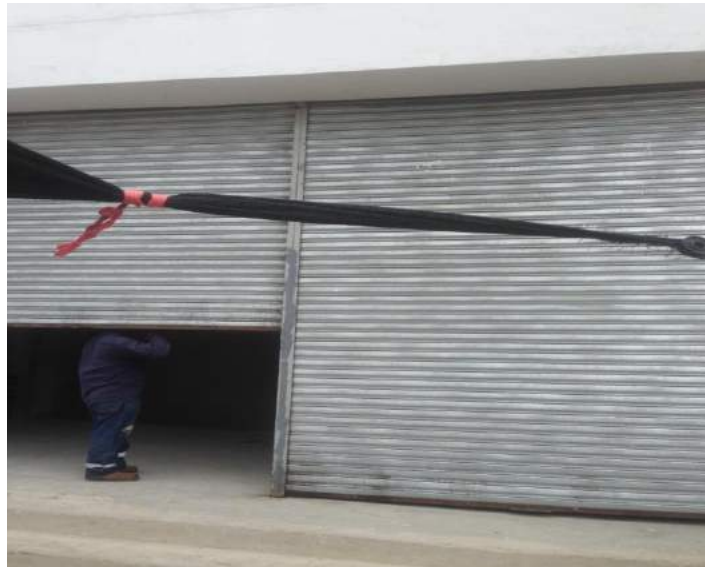
Entrada principal calle 30, con estera metálica instalada.
