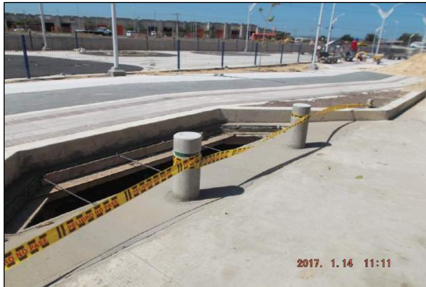
Instalación de Bolardos para protección de rejilla en zona de captación de aguas lluvias del Box coulvert.
