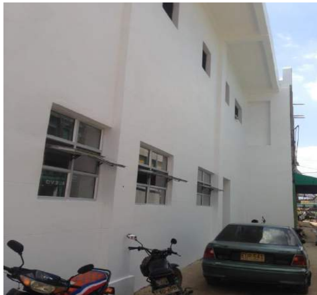
Otra vista lateral, ventanas de la parte baja ya instaladas.
