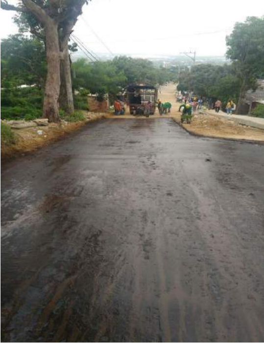
Imagen 10. Imprimación de base granular compactada.
