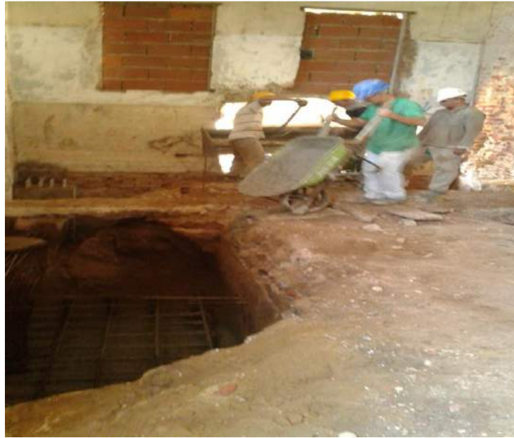
Instalación de concreto de 4000 Psi para zapatas
