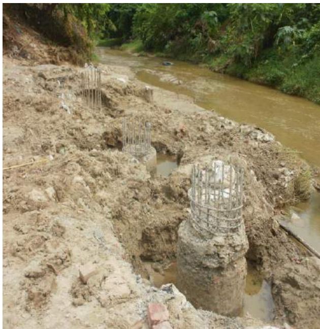
Imagen 3. Pilotes fundidos para puente.
