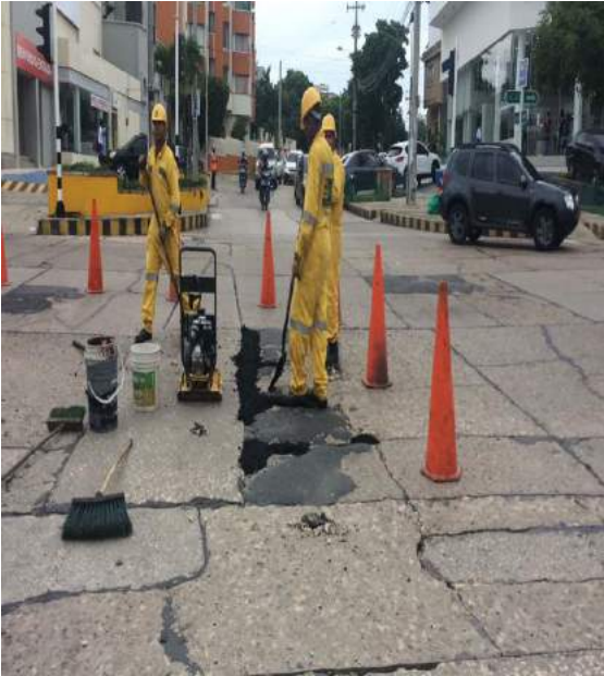
Imagen 01. Reparación de zanja hecha con anterioridad.
