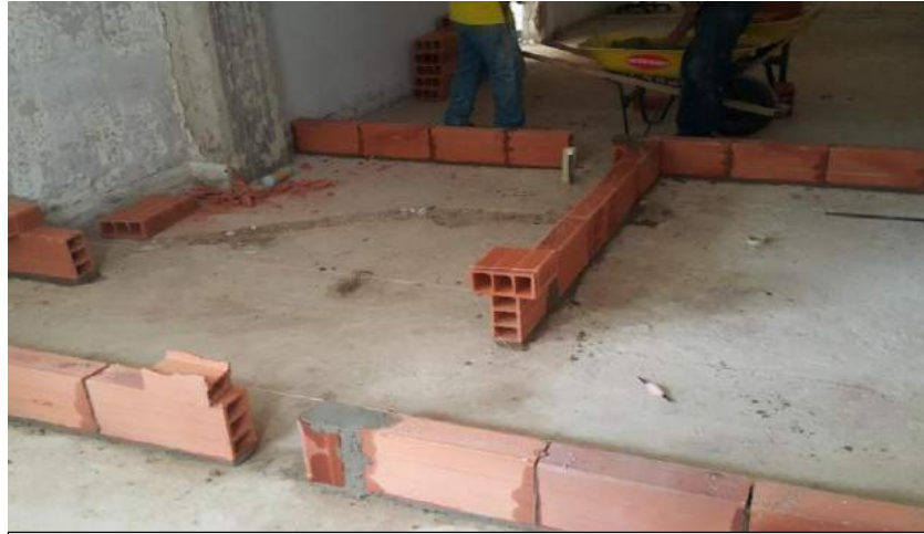
IMAGEN LEVANTE EN BLOQUE DE CEMENTO E = 0.10 METROS
