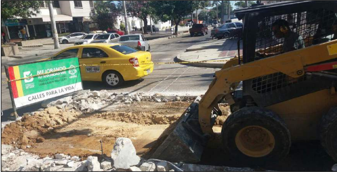
Proceso de Excavación
