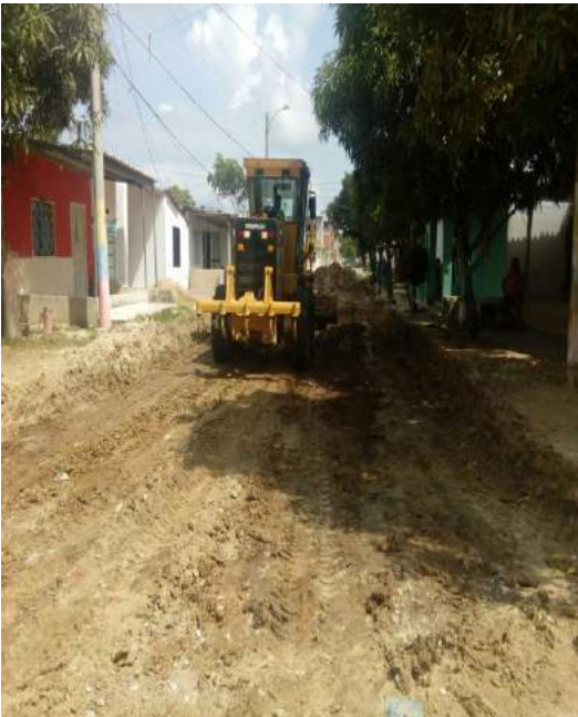
Imagen 06. Excavación de terreno en la carrera 26C.
