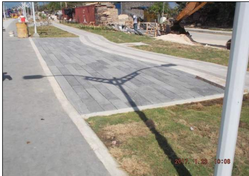
Instalación de piso tipo madera color gris en plazas de acceso a puente peatonal.
