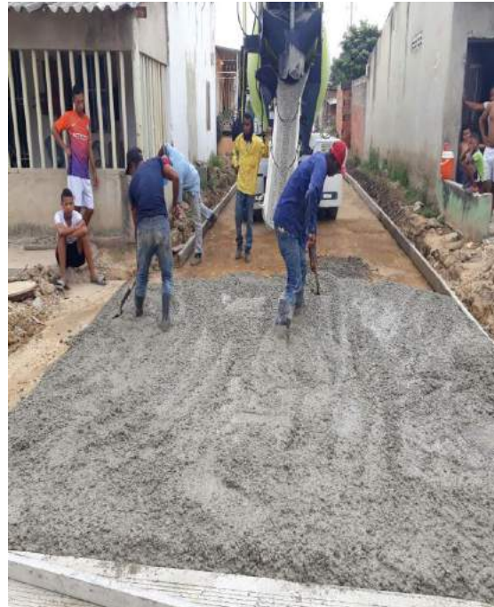
Imagen 08. Colocación de pavimento en la calle 99C.
