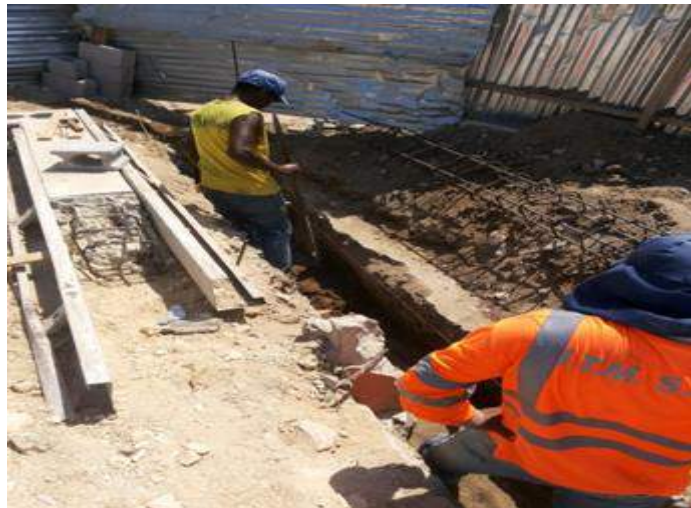
Excavación para viga.
