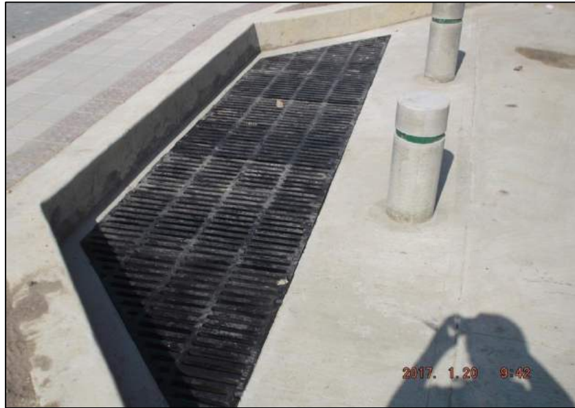
Instalación de Rejillas zona de captación aguas lluvias del box couvert.
