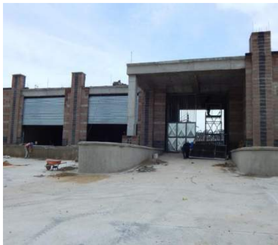
Portones de acceso zona servicios.
