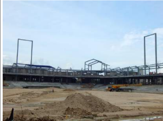
Izaje pórticos para iluminación.
