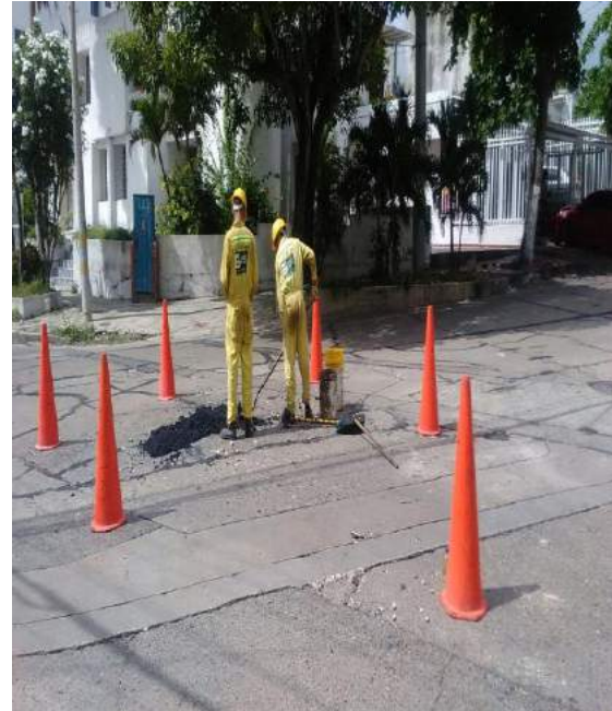
Imagen 04. Reparación de hueco en intersección.
