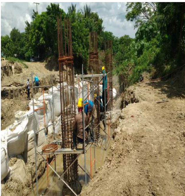
Imagen 7. Figurado de acero para columnas, Juan Mina.
