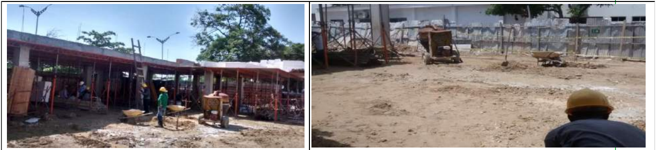
FOTO 5 Retiro de andamios de las losas. FOTO 6 Adecuacion del area del hangar
