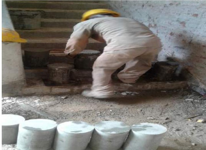
Toma de muestras de concretos para la realización de ensayos
