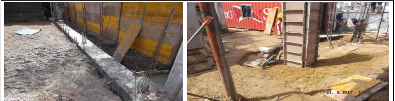
FOTO 9 Viga de cimentación para el cerramiento perimetral. FOTO 10 Vista general de la compactación del material seleccionado en el área de la zapata B1-12.
