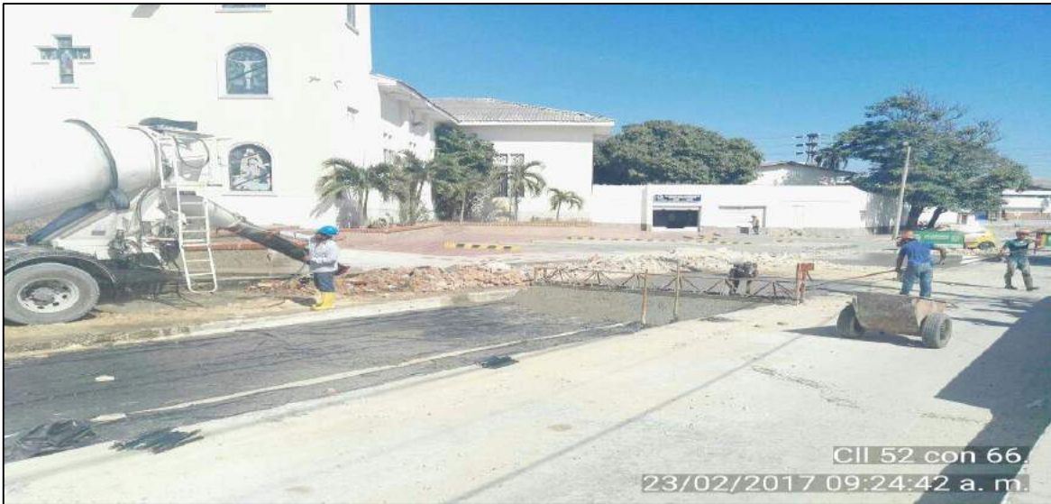
Proceso de fundida de Concreto y separación mediante plástico de fluido
