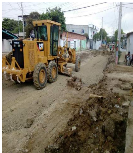
Imagen 07. Colocación de suelo cemento en la calle 82 con 26.
