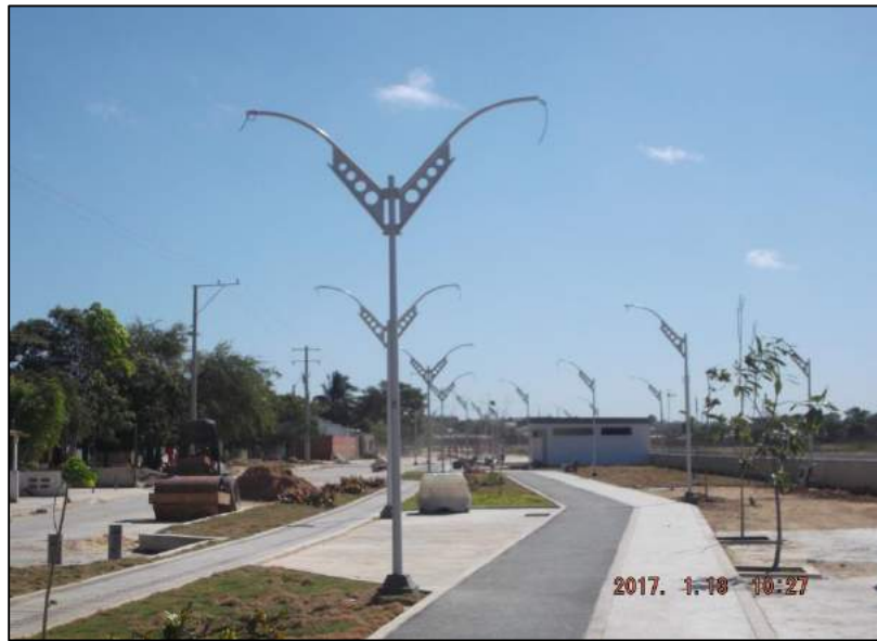
Vista general de la instalación de postes metálicos y cableados de los mismos, para iluminación del parque.
