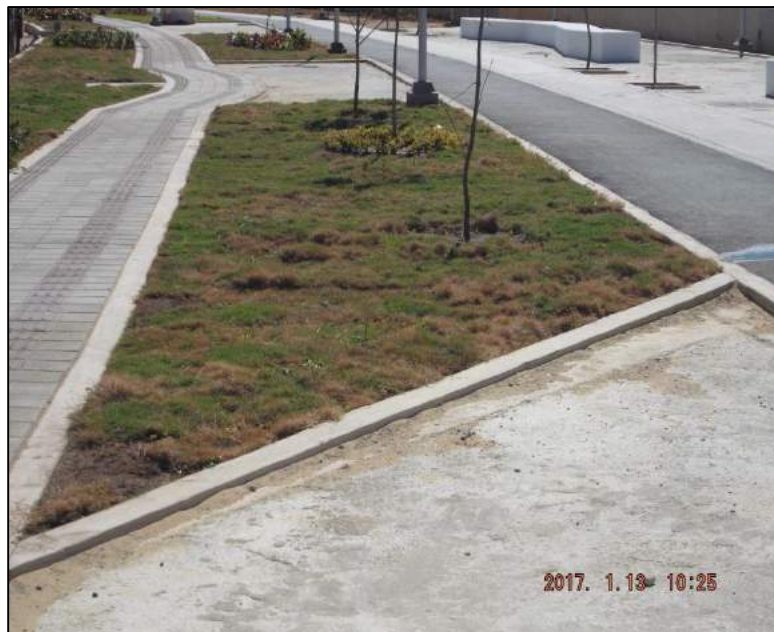
Instalación de grama tipo tapete en zona de plaza de acceso a puentes peatonales.
