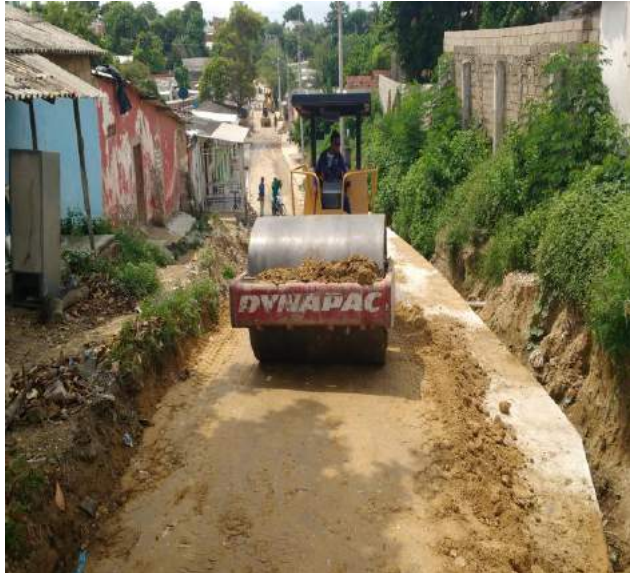
Imagen 1. Conformación de terraplén para empalme con la cordialidad, Carrera 5C, La Sierrita
