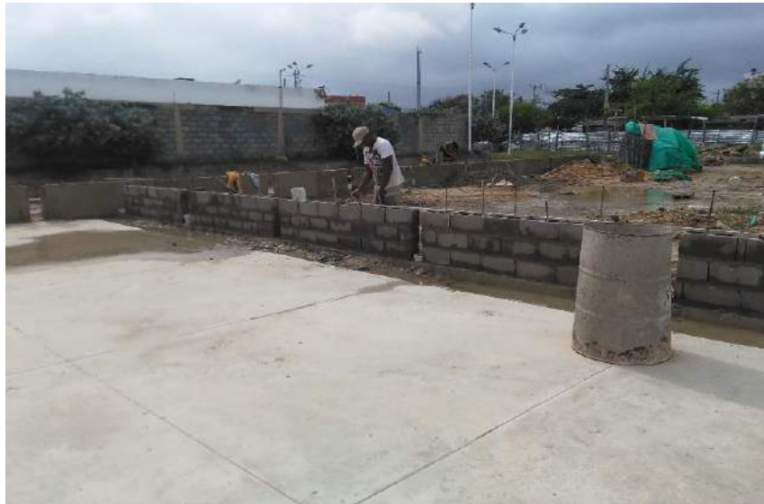
Se realiza levante de muro para cerramiento de cancha de fútbol. H = < 0.80 .
