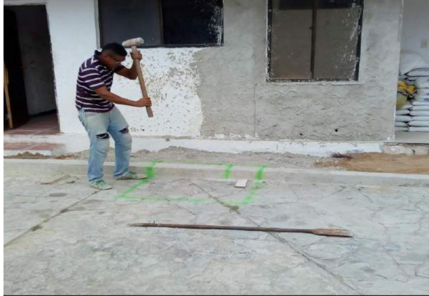
IMAGEN. DEMOLICION DE PISO PARA ZAPATAS
