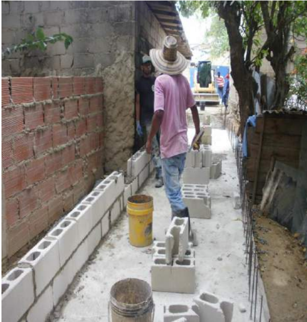
Imagen 5. Construcción de canal de la carrera 5C para evacuación de aguas de la vía, La Sierrita.
