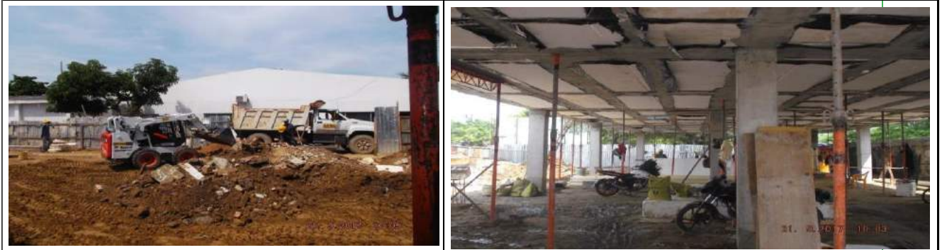
FOTO 7 Se observa el retiro del material de excavación del área de la zapata B1-12. FOTO 8 Vista general de la losa de cubierta.
