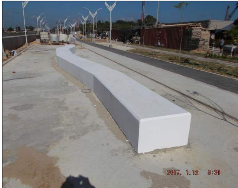
Vista de acabados de Bancas corridas en plaza de acceso a puentes peatonales.
