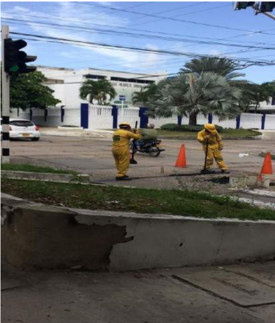
Imagen 03. Reparación de zanja.
