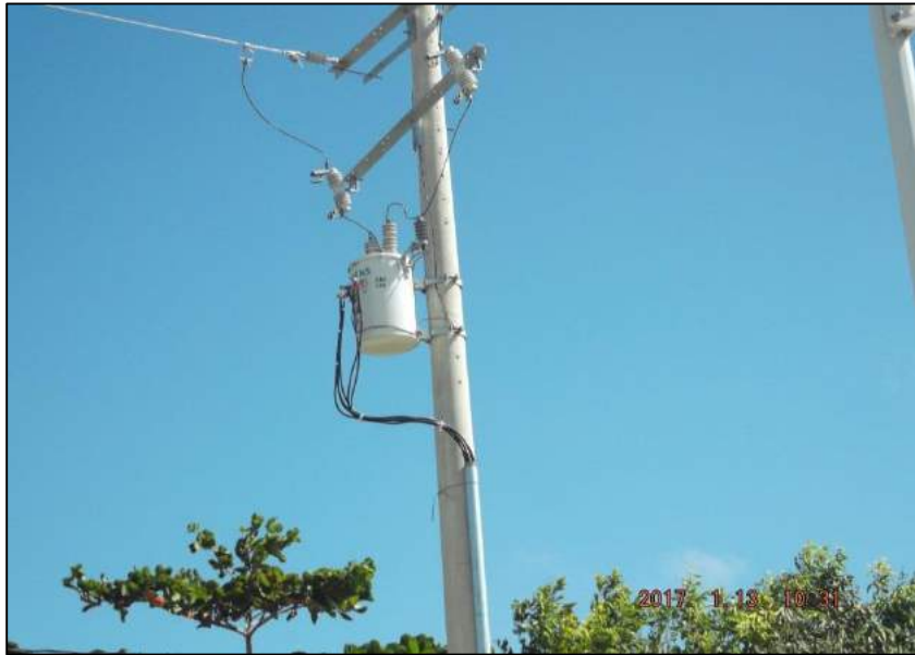
Instalación de transformador eléctrico para energización del parque.
