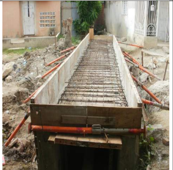
Imagen 4. Boxculvert de la Diagonal 54, Santo Domingo.
