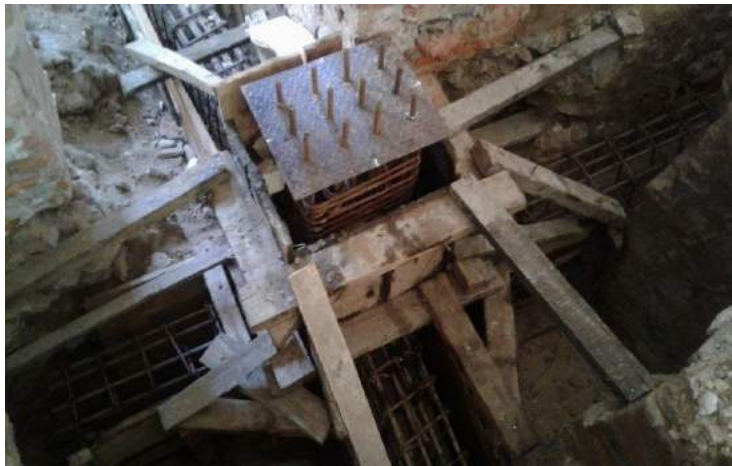
Instalación de formaleta para pedestal y vigas de enlace
