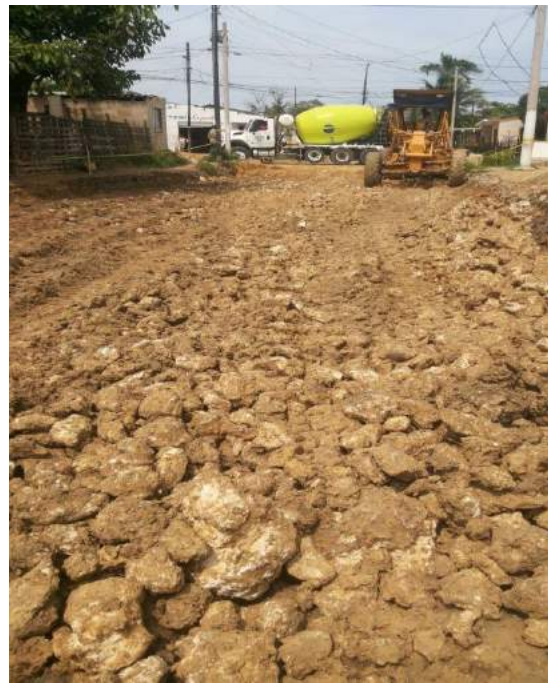
Imagen 06. Estabilización de terreno en la carrera 12A.
