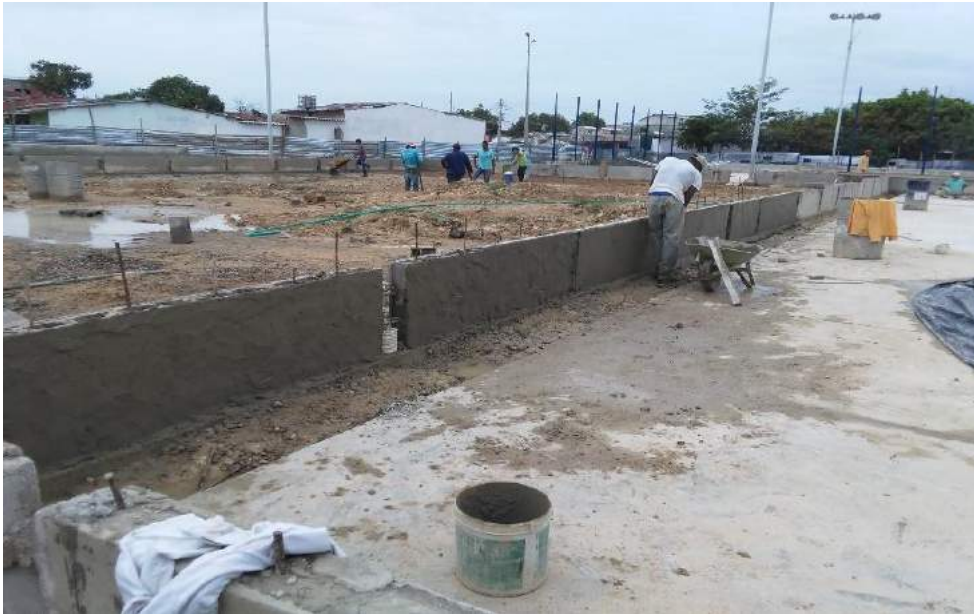
Pañete allanado sobre muro de cancha de arena. Mortero 1:4. h = < 0,80 mts.
