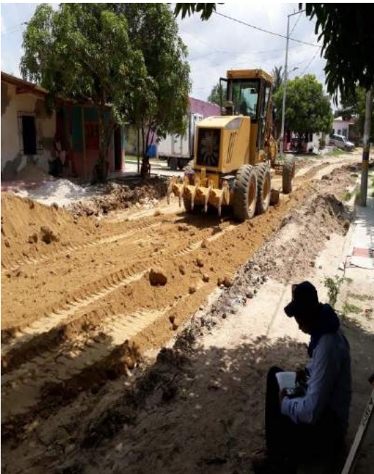
Imagen 07. Colocación de Relleno en la carrera 12A.
