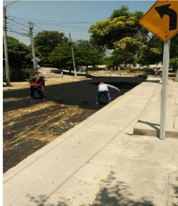
Imagen 11. Colocación de subcarpeta asfáltica (bacheo).
