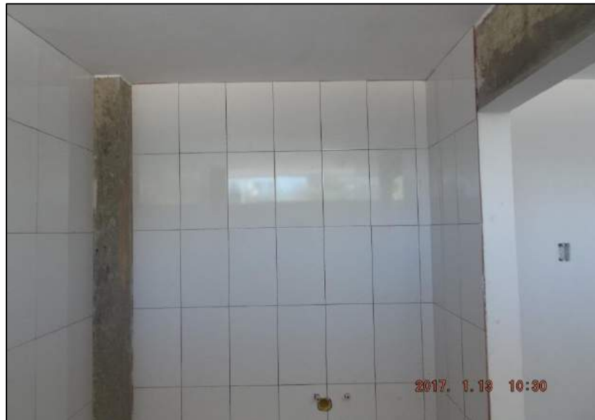
Instalación de Enchape en baño de edificio de mantenimiento.
