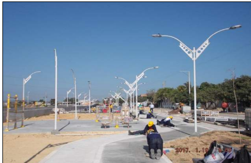
Instalación de luminarias en Postes metálicos.
