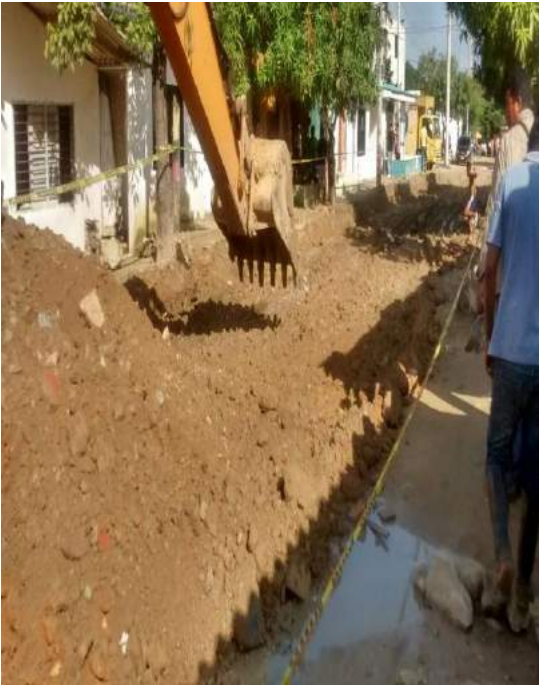
Imagen 05. Corte de terreno en la carrera 12A.
