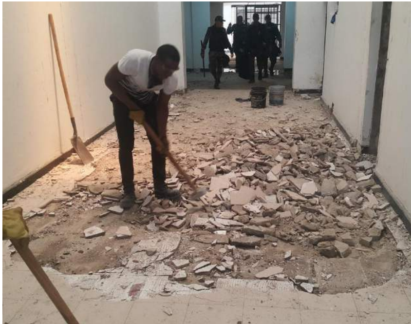
IMAGEN. DEMOLICION DE PISO Y PLANTILLA
